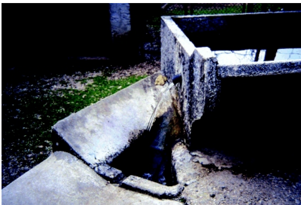
Contrada Cecchetti, particolare del sistema fonte/lavatoio
