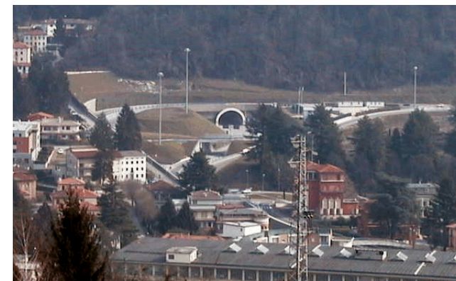
Vista dell'accesso al traforo
